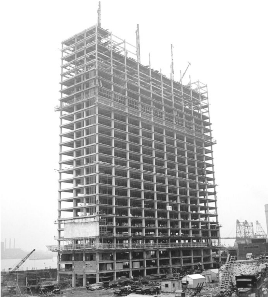
Construcción del edificio de la Secretaría de las Naciones Unidas en Nueva York (1949)
