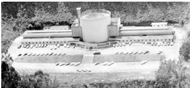
Reactor nuclear instalado en el IVNIC
